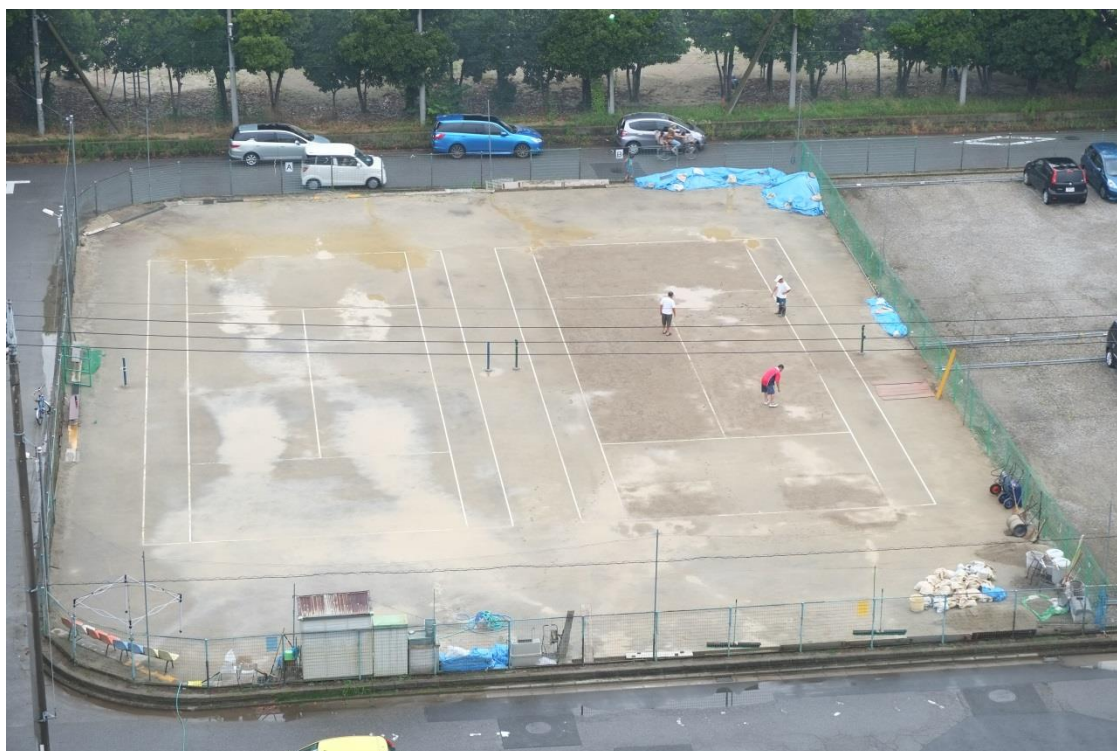
写真-1 Bコート降雨後の状態（整備後 7月 15日）排水勾配の効果確認、一部窪地に水溜りあり 窪地は後日追加盛土転圧を行った。
